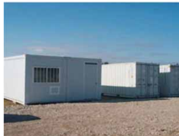
Installation de la base-vie Source : EDF Renouvelables
