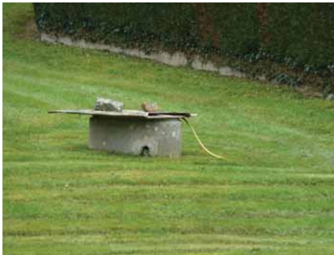
Puits implantés au sein du quartier de Maleplane, dans l'AEI
