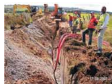
Déroutage et pose des câbles (à gauche), exemple de poste de livraison (à droite) Source : EDF Renouvelables
