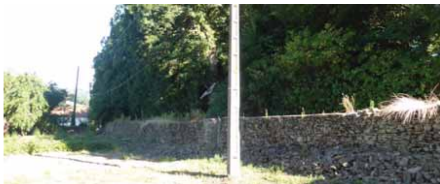
Mur marquant la frange nord de l'AEI, le long de l'impasse de Maleplane
