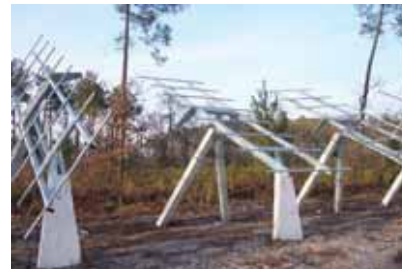
Montage des supports de la technologie « trackers » (à gauche), montage de modules sur des supports fixes (à droite) Source : EDF Renouvelables
