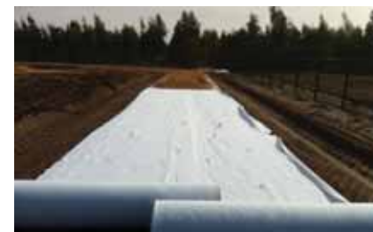
Exemple de piste renforcée créée au sein d'un projet photovoltaïque
