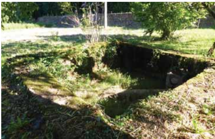
Citerne et réseau désaffectés sur la parcelle nord de l'AEI
