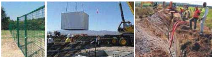
Illustration 70 : Exemple de chantier d'un parc photovoltaïque
