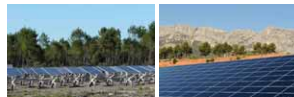
Structures solaires (à gauche: les trackers de la centrale de Gabardan (40) qui suivent le soleil ; à droite : structures fixes à Puylobrier (13)) - Source : EDF Renouvelables
