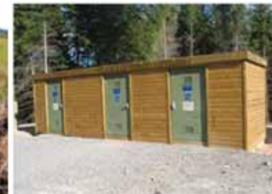
Déroutage et pose des câbles (à gauche), exemple de poste de livraison (à droite) Source : EDF Renouvelables
