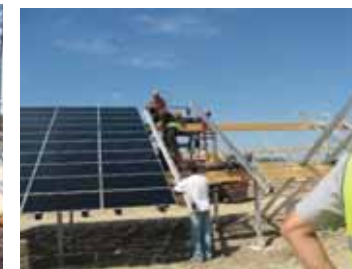
Montage des supports de la technologie « trackers » (à gauche), montage de modules sur des supports fixes (à droite) Source : EDF Renouvelables
